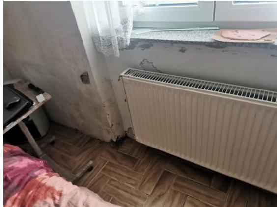
Fotografija 2: Notranjost v spalnici (uničen tlak in stene)
